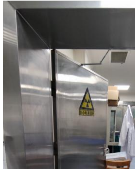
ERCp 机房工作状态指示灯和电离辐射警示标志
