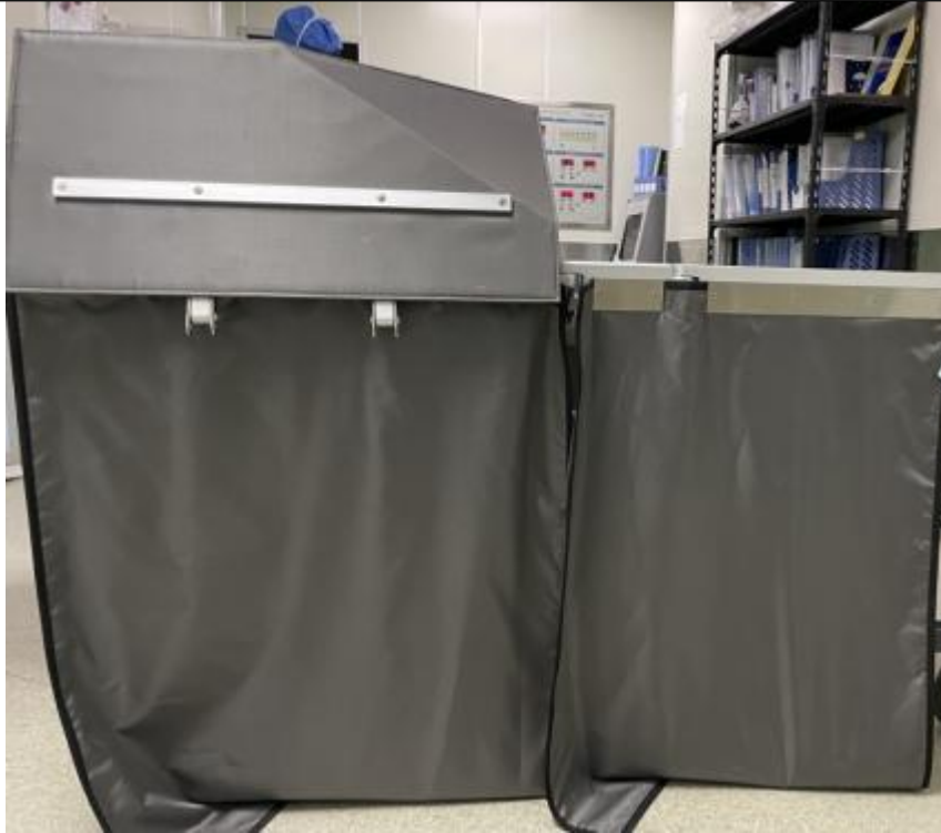
中型 C 臂机房铅屏和铅帘
