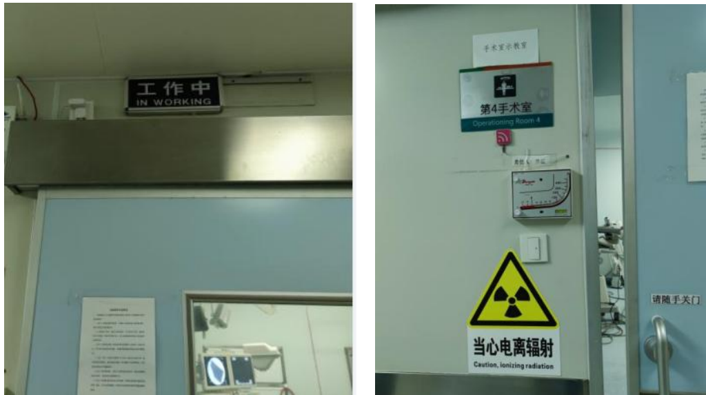
中型 C 臂机房工作状态指示灯和电离辐射警示标志
