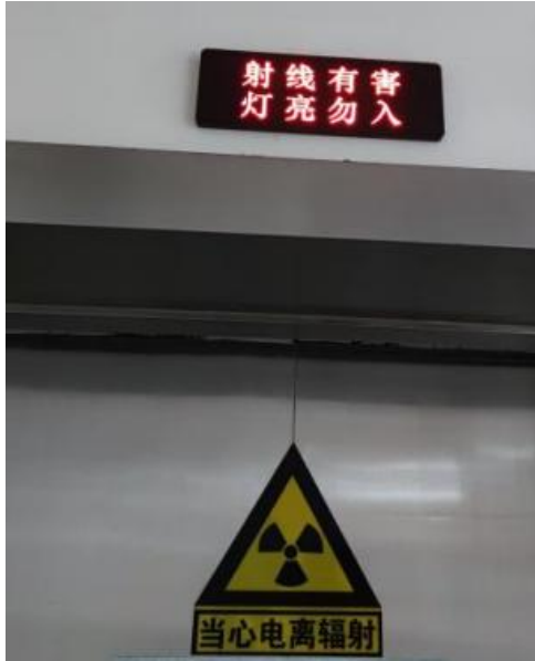
ERCp 机房工作状态指示灯和电离辐射警示标志
